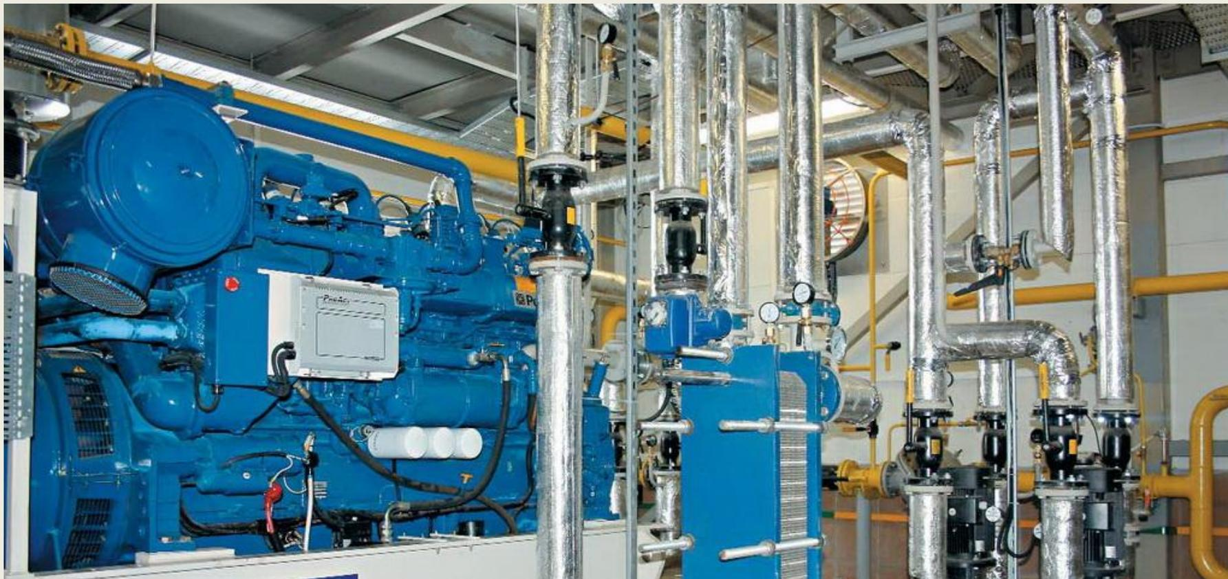
Особый бонус — это **«бесплатная» тепловая энергия**, которая получается в процессе утилизации тепла уходящих газов, как побочный продукт при выработке электроэнергии, ее можно использовать для отопления зданий, подогрева горячей воды, а при использовании чиллеров — можно получить охлаждающую систему для холодильных камер, ледовых арен, системы кондиционирования и т.п.
